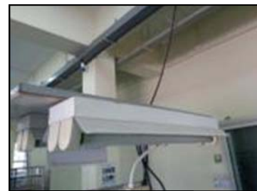
รูปที่ ๓-๔ ติดตั้งแผ่นสะท้อนแสง (Reflector)
