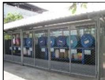
รูปที่ ๓-๘ จัดทำเขื่อน / คันกั้น เพื่อป้องกันการปนเปื้อนกรณีสารเคมีหกรั่วไหล
