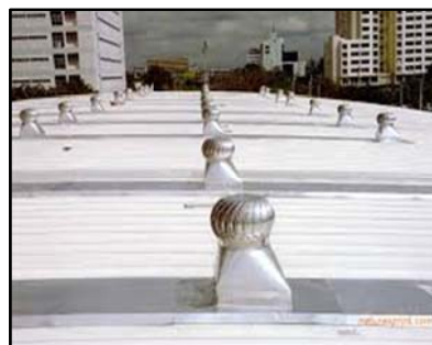
รูปที่ ๕-๙ พัดลมระบายอากาศชนิดติดตั้งบนหลังคาอาคาร
