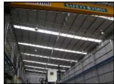
รูปที่ ๓-๖ ติดตั้งหลังคาโปร่งแสง
