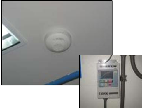
รูปที่ ๓-๒๑ ติดตั้งอุปกรณ์ตรวจจับ ควัน / ก๊าซ รั่วไหล
