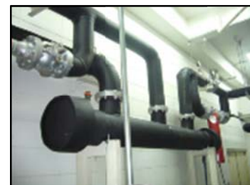
รูปที่ ๓-๓ ติดตั้งฉนวนหุ้มท่อน้ำหล่อเย็น
