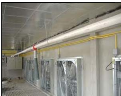
รูปที่ ๕-๘ พัดลมระบายอากาศชนิดติดตั้งที่กำแพง
